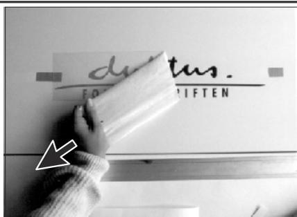
8 - Rakeln Sie dann nochmals über die ganze Fläche. Jetzt das Transferpapier wie abgebildet vorsichtig abziehen. Achten Sie genau auf den Abziehungswinkel auf der Abbildung.
