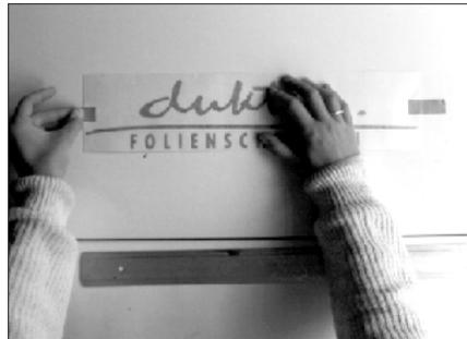
2 - Die Folienschrift mit einem zerreißbaren Klebeband auf Position montieren, eventuell Position mit Stift zusätzlich markieren.
